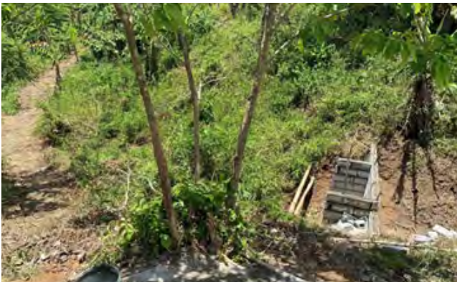
Le barrage pour la collecte des eaux de pluie.
